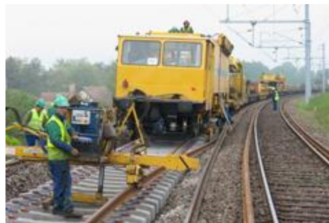
Longs Rails soudés sur traverses béton
