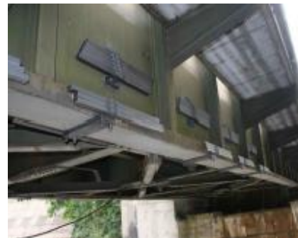
Absorbeur sur platelage
