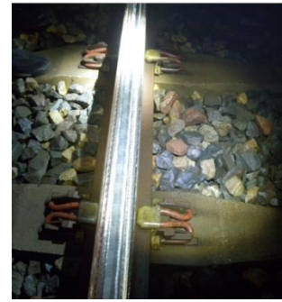
rail après meulage
