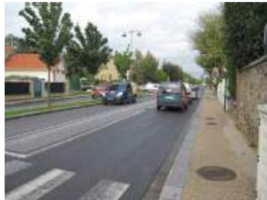
AV. DU GÉNÉRAL LECLERC Source : Google Street View
