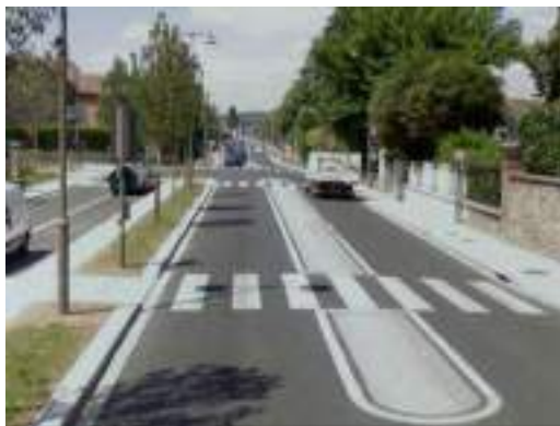
AV. DU GÉNÉRAL LECLERC Source : Google Street View
